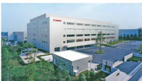
Headquarters (Kanagawa pref.)
